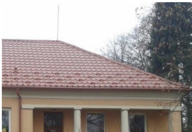
obr. /29/ Pohled na střešní plášť doplněný systémem protisněhových zábran
