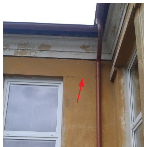
obr. /8/ Vodorovná trhlina v místě horního rohu okenního otvoru
