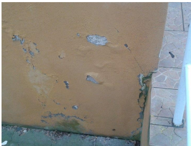
obr. /33/ Opadávající fasáda (v místě předloženého schodiště)
