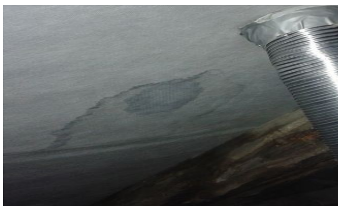
obr. /24/ Stopy úkapů na doplňkové hydroizolaci svědčící o možném defektu ve střešní krytině
