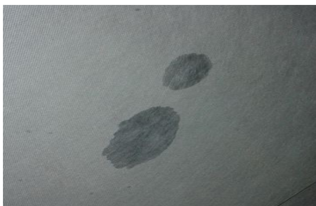
obr. /27/ Skvrny na doplňkové hydroizolaci od neznámé látky
