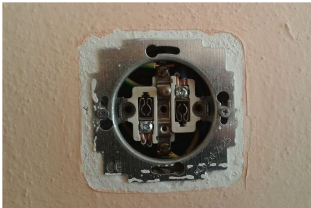
obr. /39/ Kontrola zapojení elektrické zásuvky
