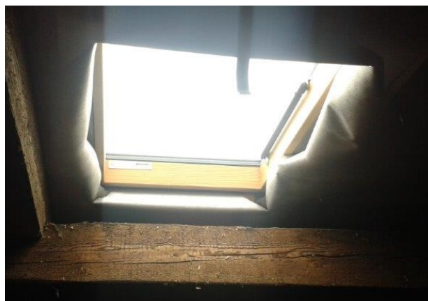
obr. /30/ Vadné opravení doplňkové hydroizolační vrstvy střešního výlezu
