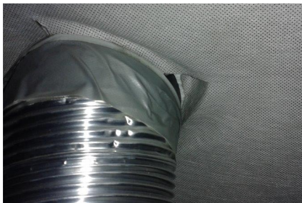
obr. /23/ Netěsnosti prostupů přes pojistnou hydroizolační vrstvu
