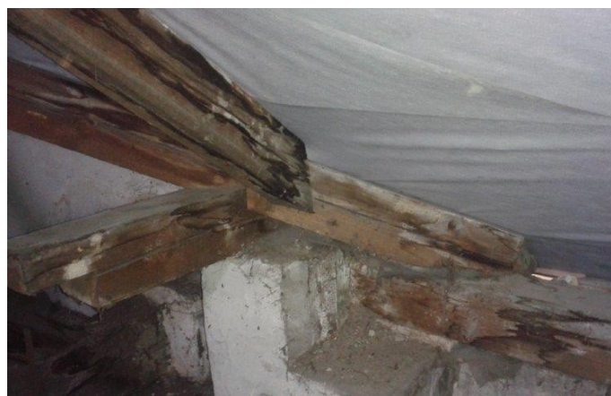
obr. /26/ Stopy od zatékání srážkové vody na prvcích krovu (pravděpodobně z doby před provedením opravy střešní krytiny)
