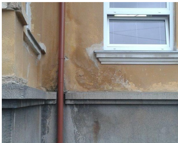
obr. /34/ Fasáda smáčená vodou v místě střešního svodu
