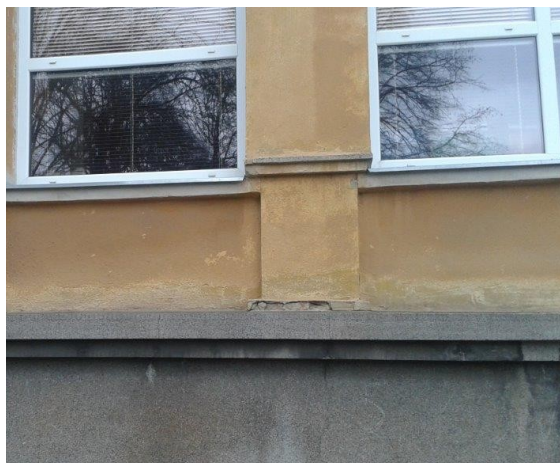
obr. /31/ Absence oplechování římsy nad soklem, degradace omítky nad římsou vlivem odstříkující vody
