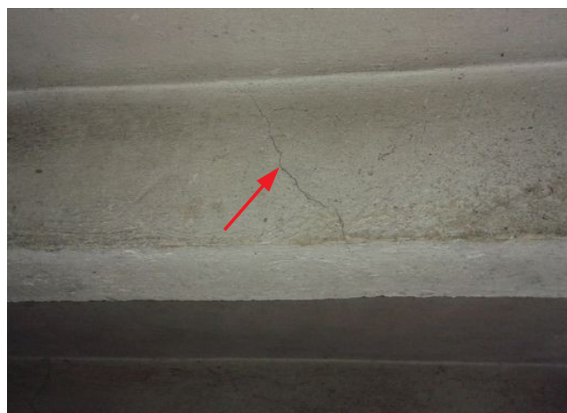
obr. /12/ Šikmé trhliny v nosnících, které vynášejí stropní konstrukci suterénního podlaží
