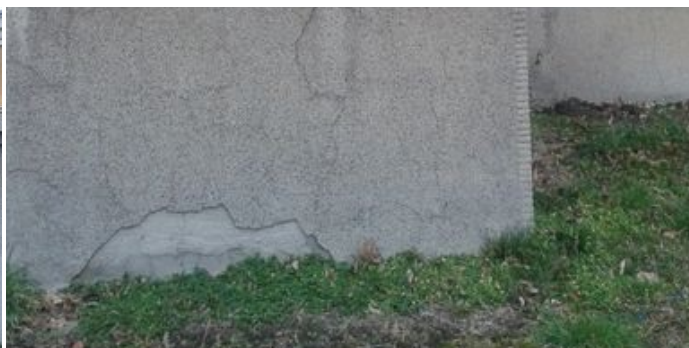
obr. /20/ Ze dvora objektu se okolo obvodových stěn nenachází okapový chodníček a stávající terén není vyspádován od objektu
