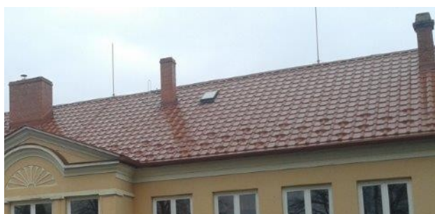
obr. /21/ V místě komínových těles se nenachází revizní lávky
