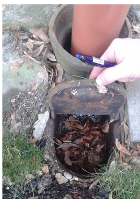
obr. /47/ Lapač střešních naplavenin je zanesený listím
