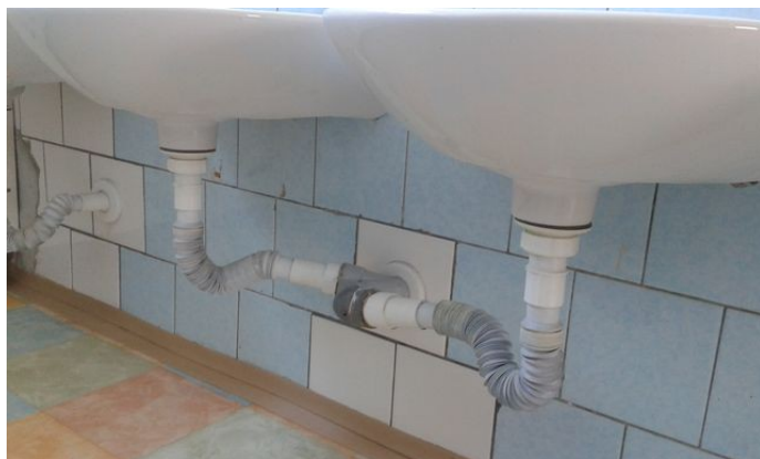
obr. /37/ Zápachová uzavírka s flexibilní trubicí
