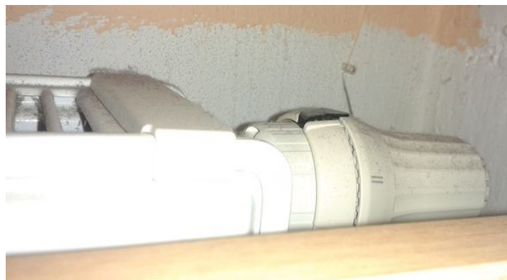
obr. /44/ Deskový ocelový radiátor je doplněn termostatickou hlavicí
