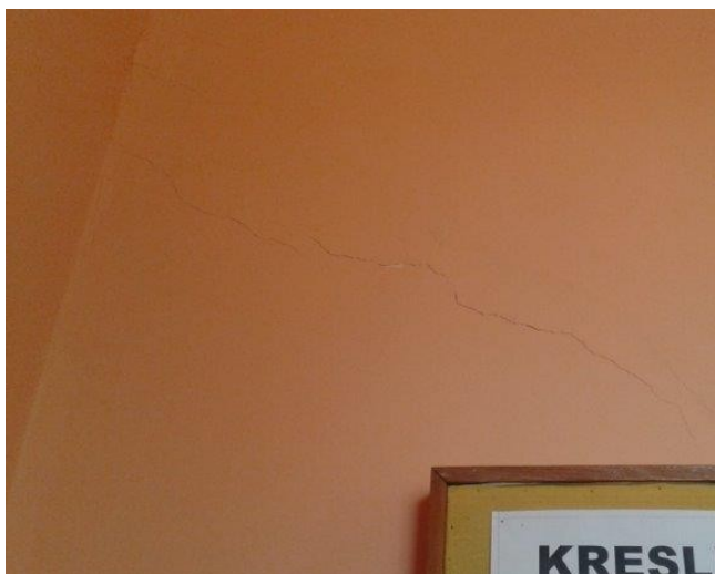
obr. /9/ Trhliny v rohu obvodového zdiva (pohled z vnitřní strany objektu)
