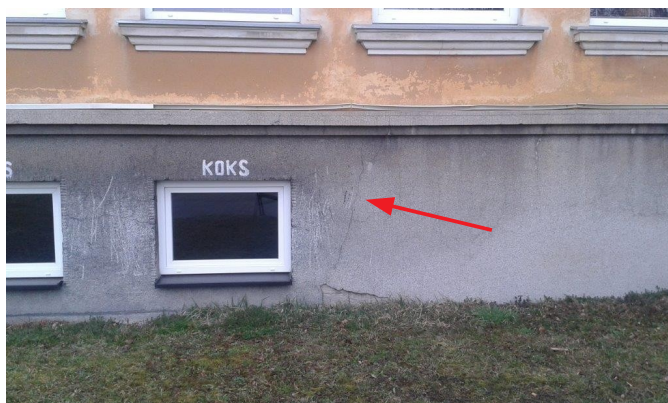
obr. /7/ Svislá trhlina v soklovém zdivu v místě přechodu z nepodsklepené části objektu na podsklepenou část objektu
