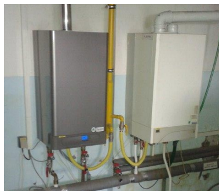
obr. /46/ Plynový kotel umístěný v suterénu objektu
