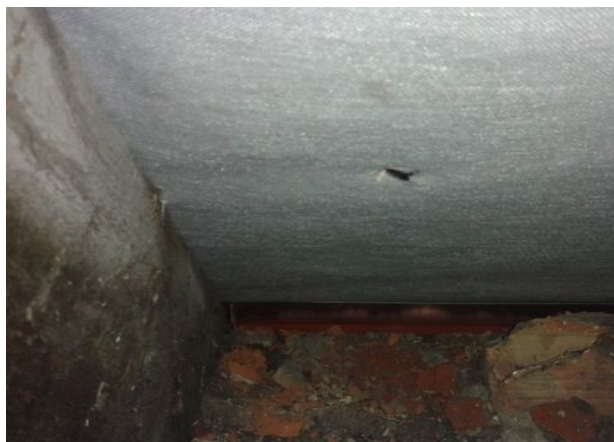
obr. /25/ Mechanické poškození doplňkové hydroizolační vrstvy
