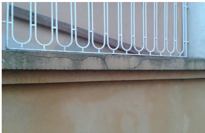
obr. /32/ Degradace povrchu předložených konstrukcí
