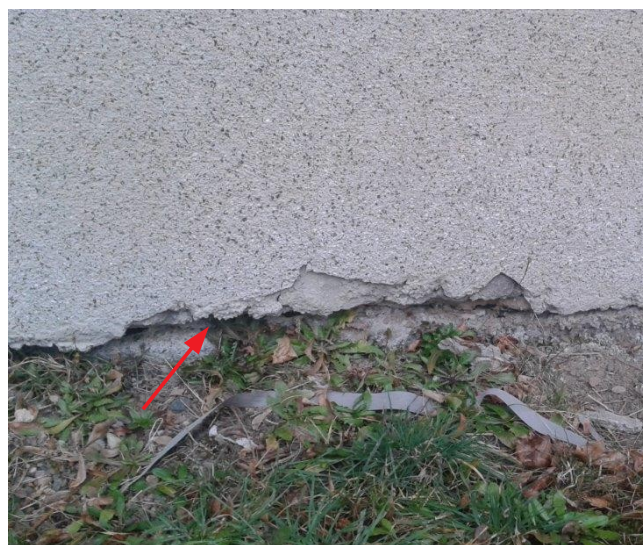
obr. /4/ Poloha hydroizolační vrstvy v obvodové stěně
