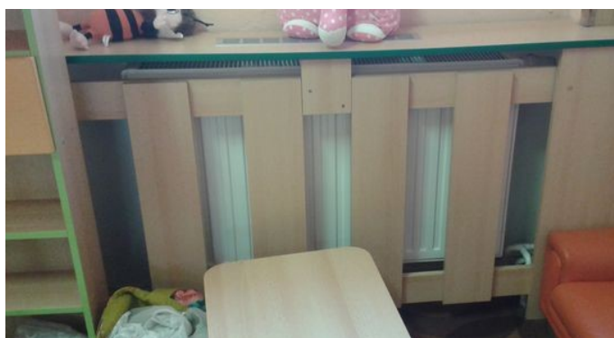
obr. /45/ Deskové radiátory jsou v místnostech určených pro pobyt dětí chráněny obložením z materiálu na bázi dřeva
