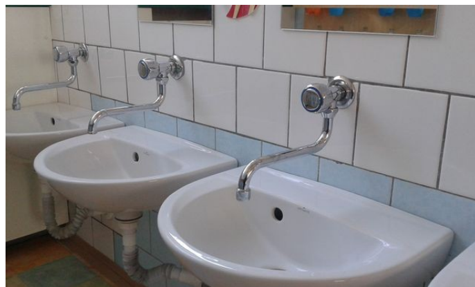
obr. /38/ Stávající otočné výtokové armatury na dětském WC
