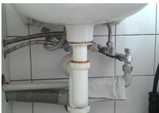
obr. /35/ Původní odpadní zápachová uzavírka
