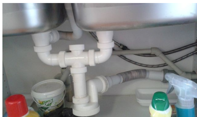
obr. /36/ zápachová uzavírka po rekonstrukci
