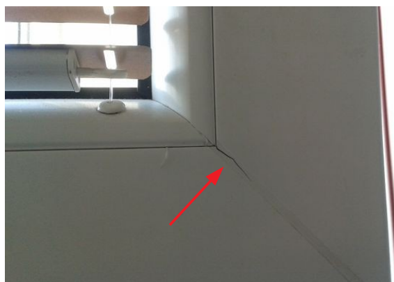
obr. /16/ Trhlina ve svaru profilu rámu křídla
