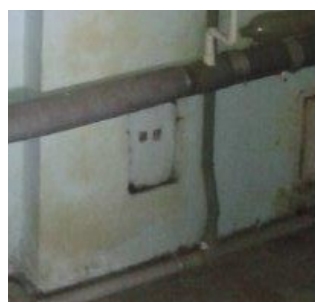
obr. /22/ Původní vymetací otvor komínového tělesa
