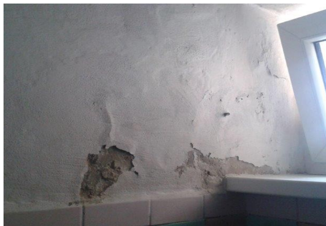
obr. /6/ Opadávající vlhká omítka na suterénních WC
