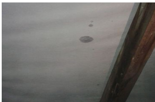
obr. /28/ Skvrny na doplňkové hydroizolaci od neznámé látky
