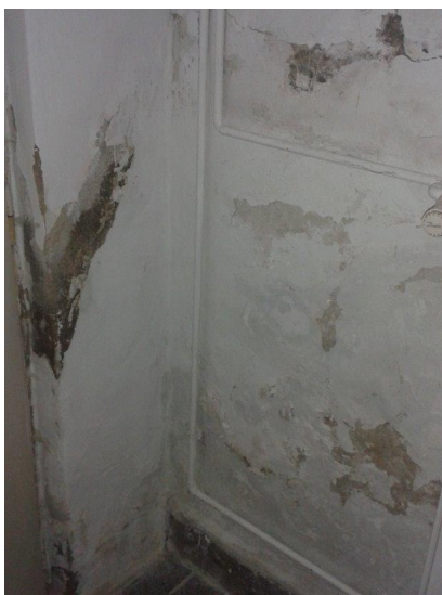
obr. /3/ Suterénní stěna s projevy vlhkostních poruch, dochází k odpadávání omítek
