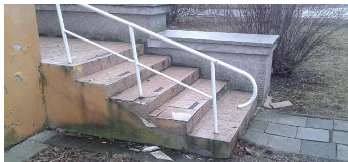
obr. /18/ Keramický obklad vnějšího schodiště je značně poškozený a odpadává
