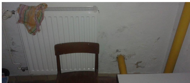
obr. /49/ Prostup plynové přípojky skrz suterénní stěnu je veden v ocelové chráničce.
