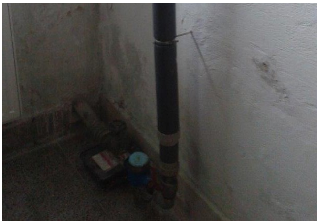
obr. /5/ Plíseň v rohu u vodoměrné sestavy
