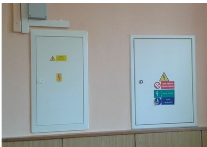
obr. /41/ Rozvaděč elektrické energie je umístěn ve výklenku vnitřní stěny
